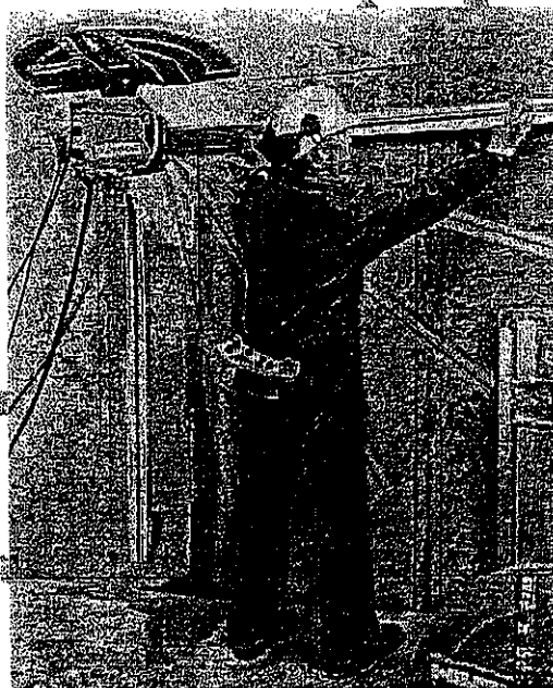
Σχήμα 2: Κοπή τοίχου με δισκοπρίο επί τροχίων καθοδήγησης
